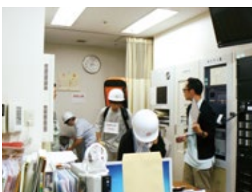
防災センター(災害対策本部)
